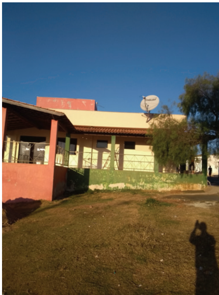
ANTES DA REFORMA E AMPLIAÇÃO DO PSF PINHEIRINHO
