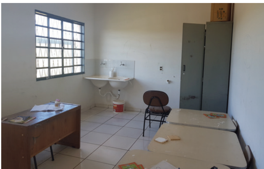
ANTES DA REFORMA NA UNIDADE CIDADE ESCOLA (PONTO DE APOIO DA VILA PROMESSA)
